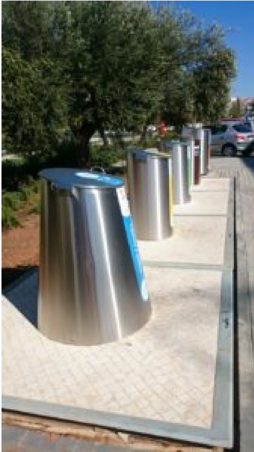
INSTALAÇÃO DE DEZ CONTENTORES SUBTERRÂNEOS – FOTO | CM S.B.ALPORTEL
