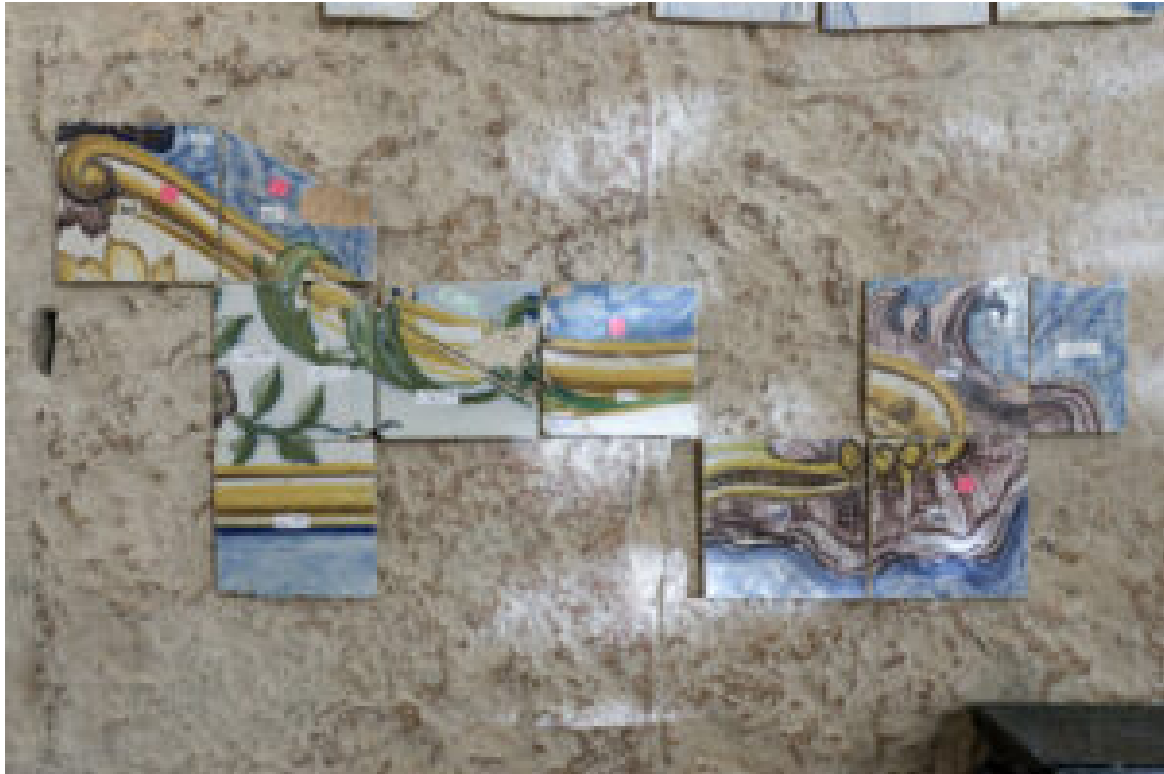
Palácio Nacional de Queluz – Recuperação do Canal dos Azulejos. Créditos: PSML/EMIGUS
