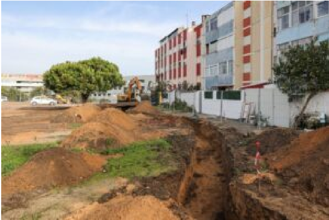
Obra de requalificação. Foto: CM Setúbal
