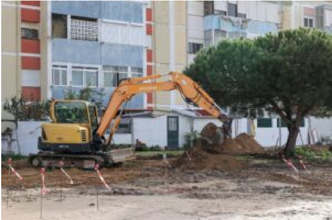
Obra de requalificação. Foto: CM Setúbal
