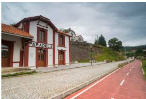
Ecopista do Vouga – Paradela ( antiga estação da CP) . Foto CM SEVER DO VOUGA
