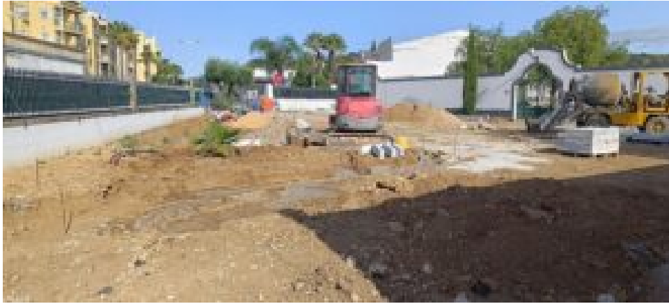
Obras no cemitério municipal. Foto: CMSBAIportel
