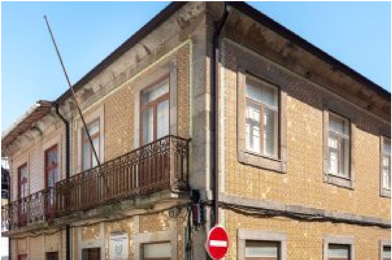
Edifício e Escola de Música – FOTO | VÍTOR LIMA/OCidadão
